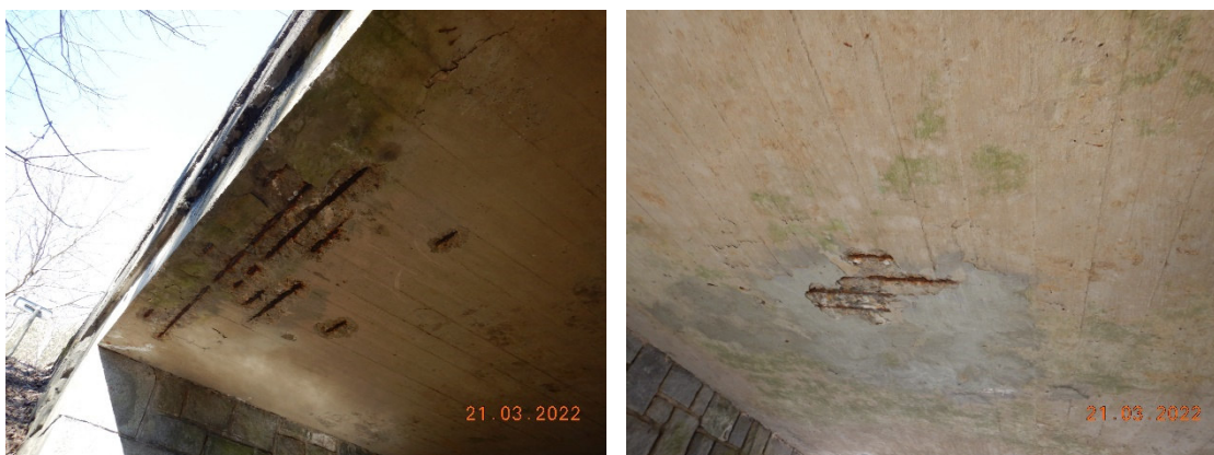
Obrázek 6: Typický stav na pohledu nosné konstrukce
