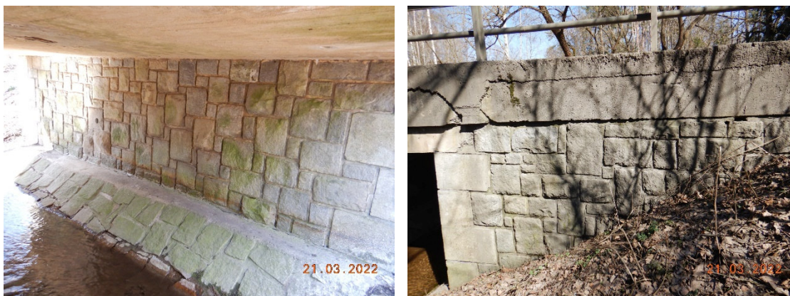
Obrázek 7: Typický stav kamenného zdiva spodní stavby (opěra a křídlo)
